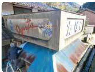
トタン屋根を塗装する DIYボランティア
